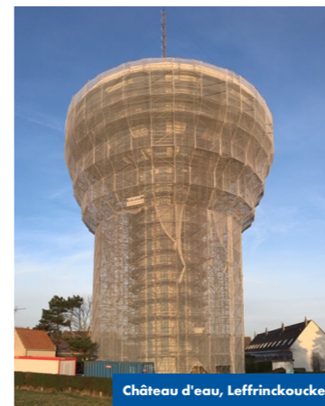
Château d'eau, Leffrinckoucke
