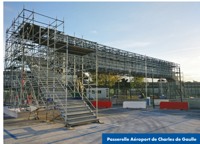
Passerelle Aéroport de Charles de Gaulle
