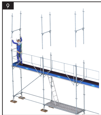
• Mise en place des cadres courants
