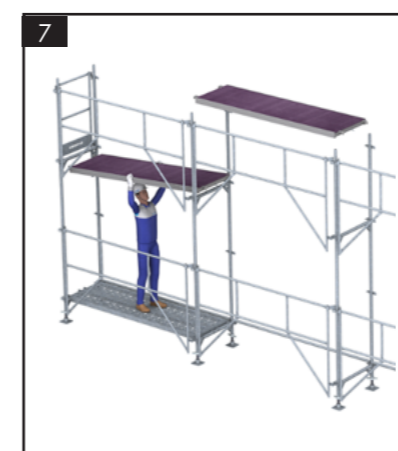
• Mise en place des planchers supérieurs.
