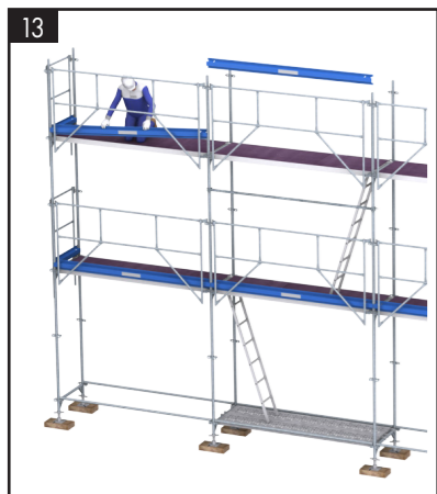
• Installation des plinthes. • Continuez le montage en respectant les étapes 9 à 13. • Contrôle de l'échafaudage et pose du procès verbal de vérification dans la pochette du panneau "accès interdit".
